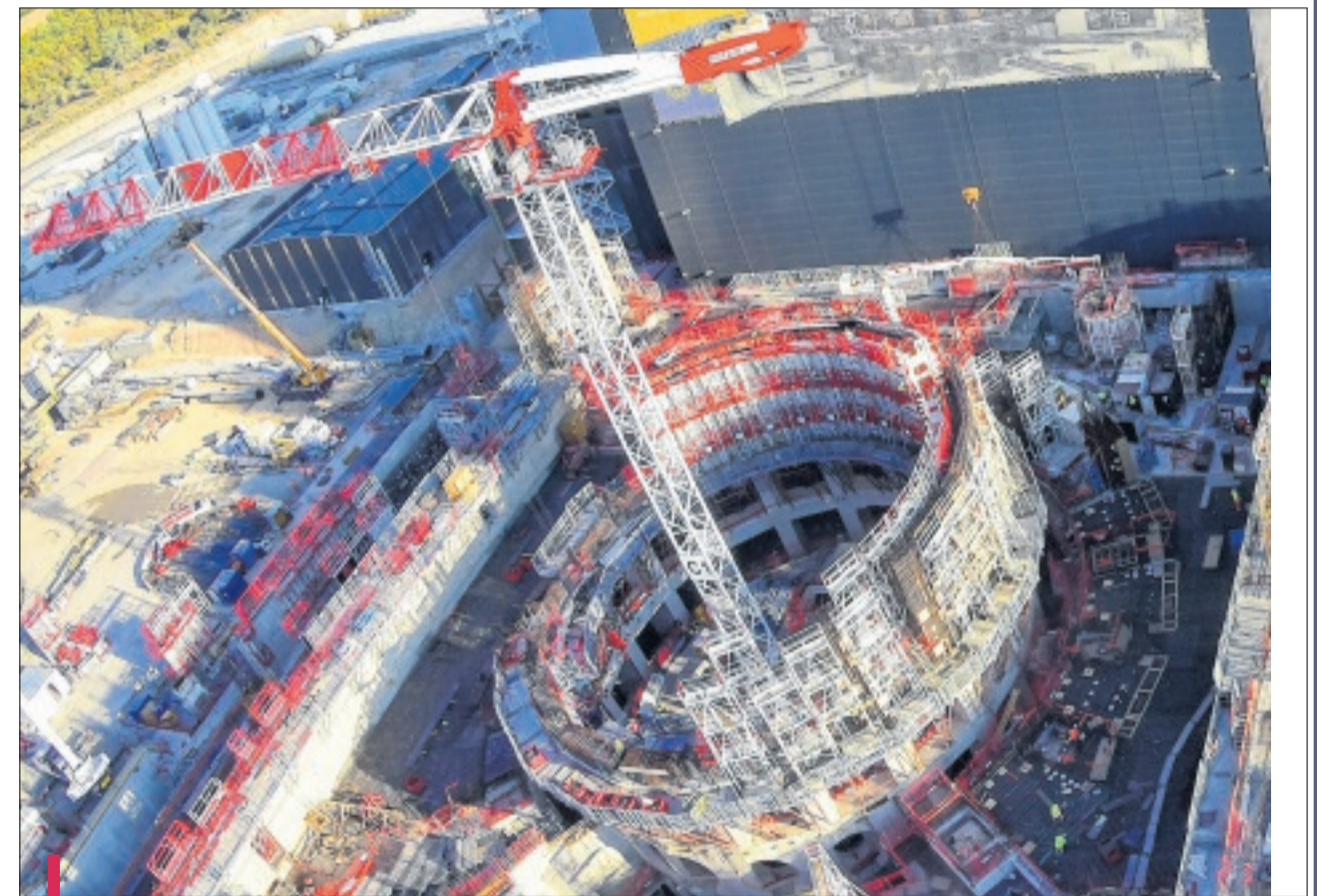
La société de Frédéric Thirion (►) réalise les armatures du bâtiment principal du Tokamak d'Iter.
