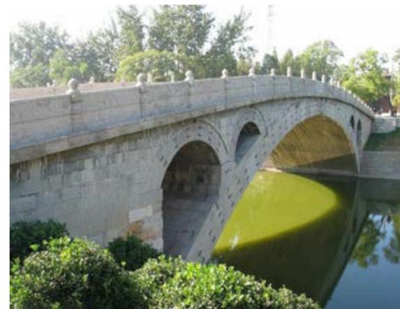
Le pont de Zhaozhou (ou pont d'Anji) achevé vers l'an 605, est considéré comme le pont en maçonnerie à arc segmentaire (à voûte surbaissée) et à tympan ouvert le plus ancien du monde
