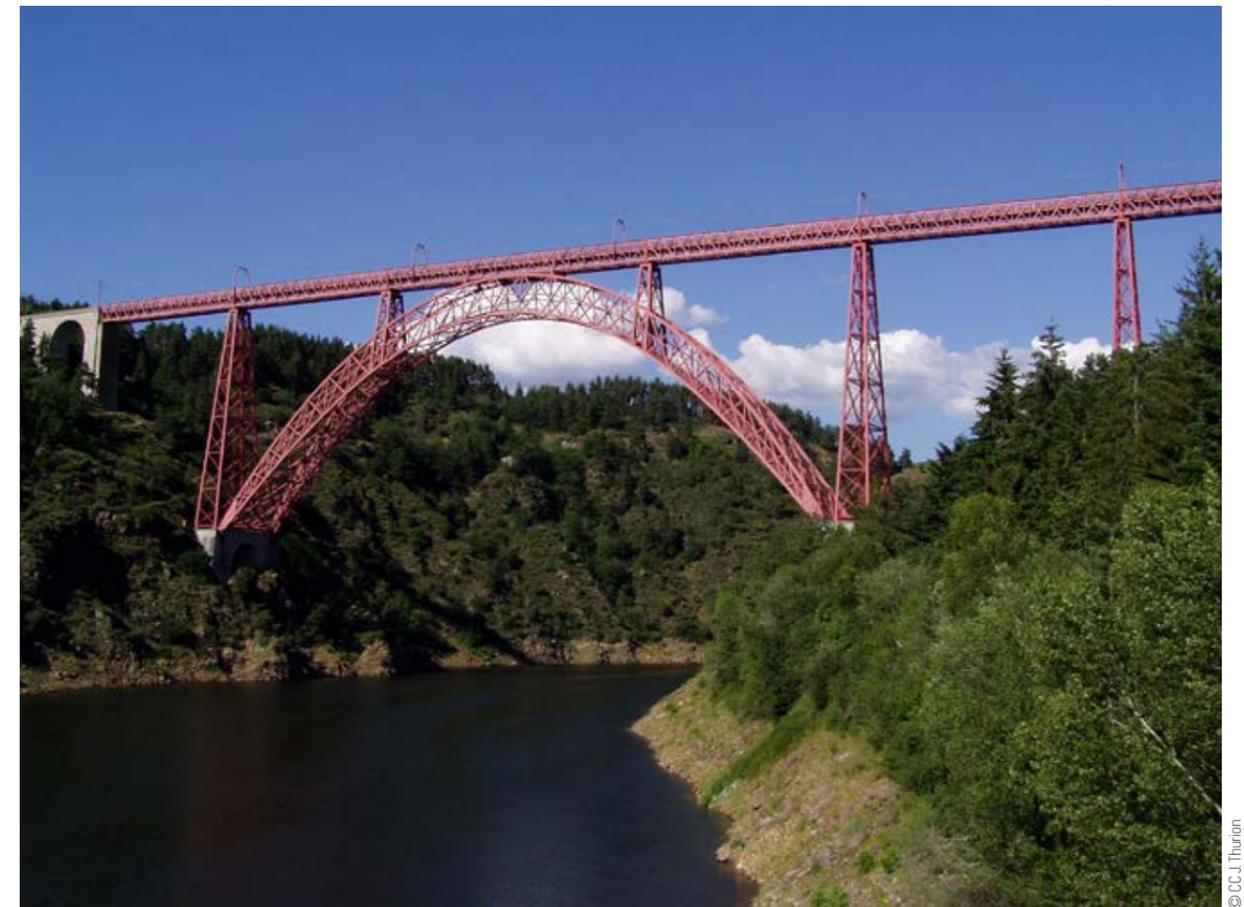
Viaduc de Garabit (Cantal, France) avec sa portée de 164 m, un ouvrage ferroviaire entièrement métallique, construit par la société Gustave Eiffel & Cie et achevé en 1884
